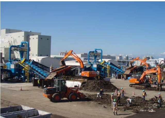
写真-3 中間処理施設全景
