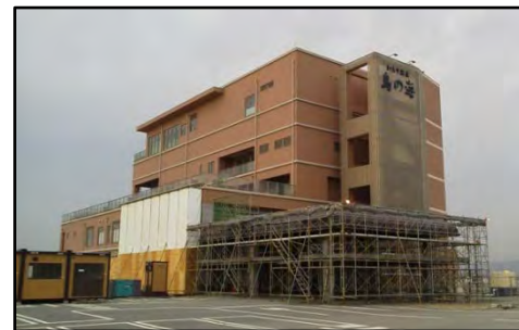
写真 4-1 「わたり温泉 鳥の海」改修状況
