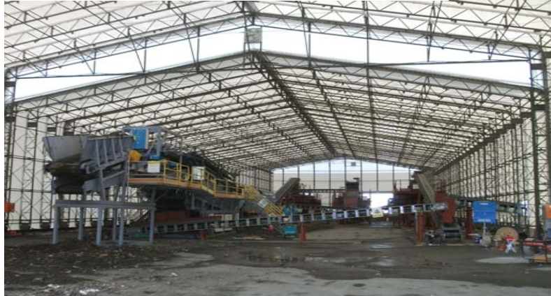
二次仮置場 破碎選別プラント
