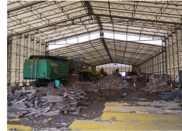
図7. 破砕選別プラントへのテント設置
