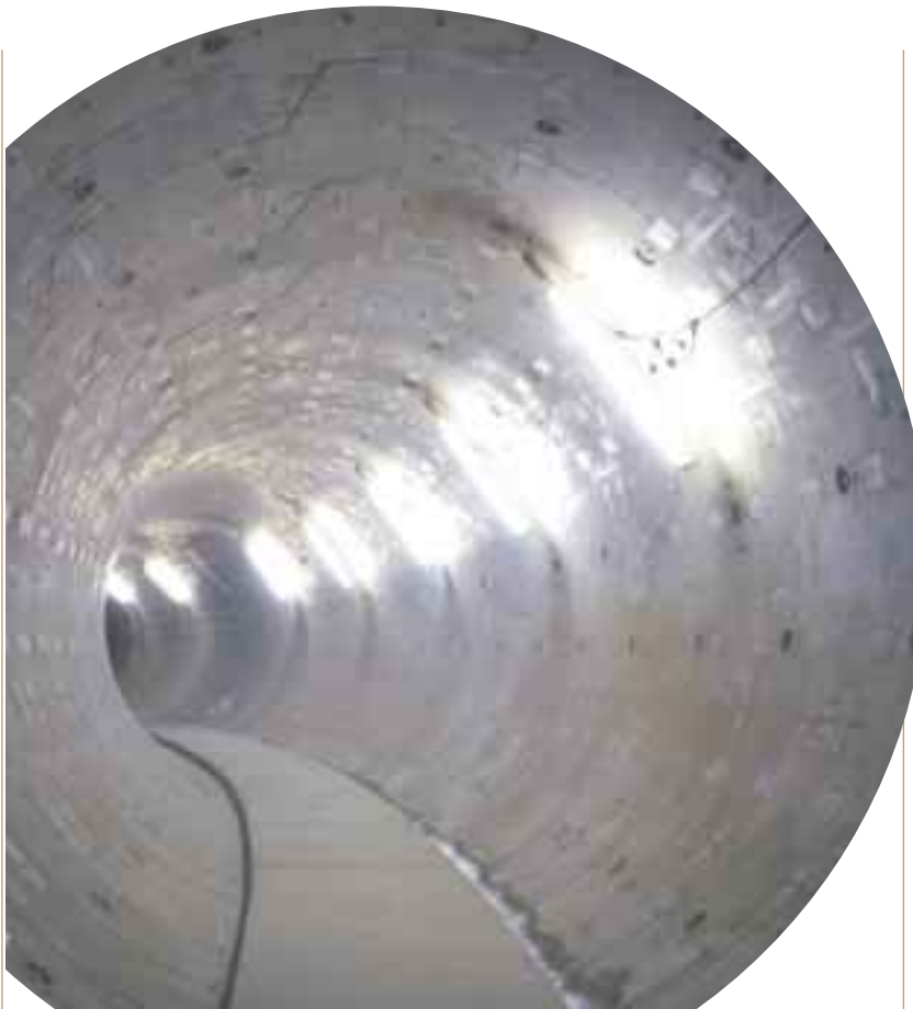
配管・配線を収容する前の共同溝
