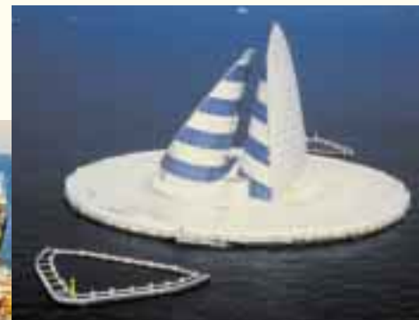
川崎人工島換気塔の工事
