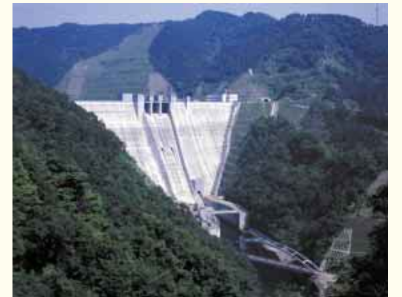
相模川水系の中津川に設けられている宮ヶ瀬ダム(堤体の高さ=156m、総貯水量=約2億立方メートル)
