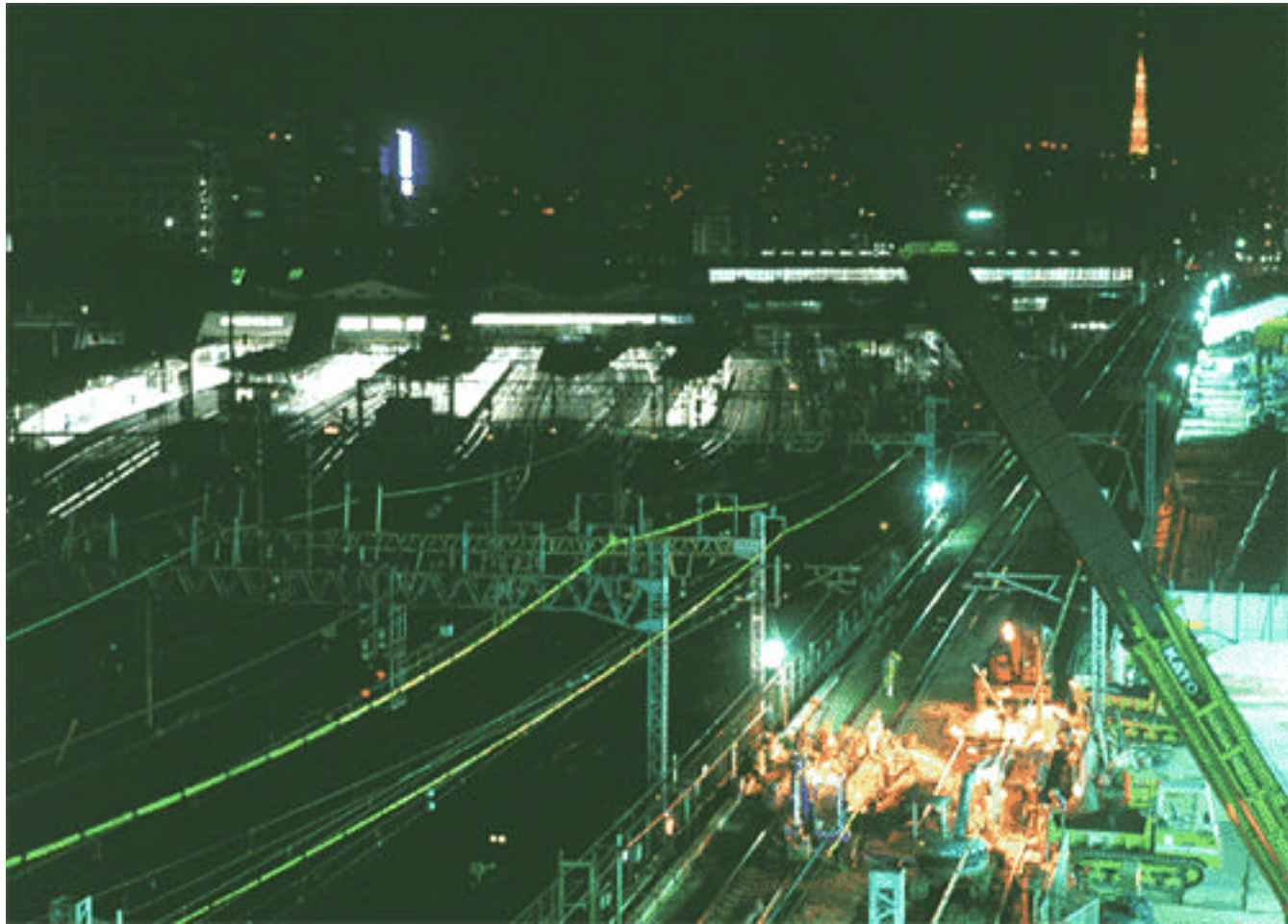
夜間に行われている、線路の新設工事
