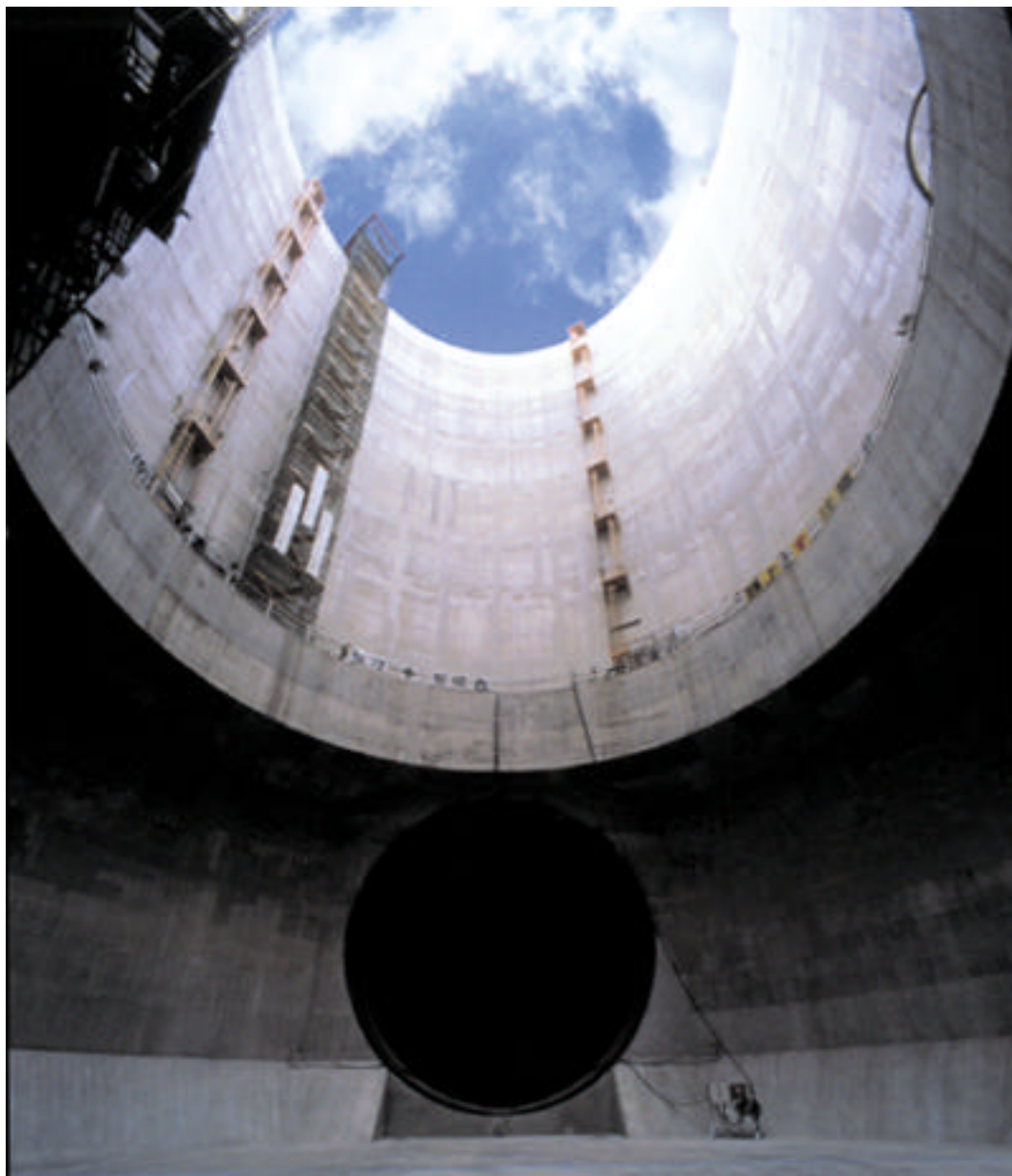
地下放水路の中から上を見上げたところ
