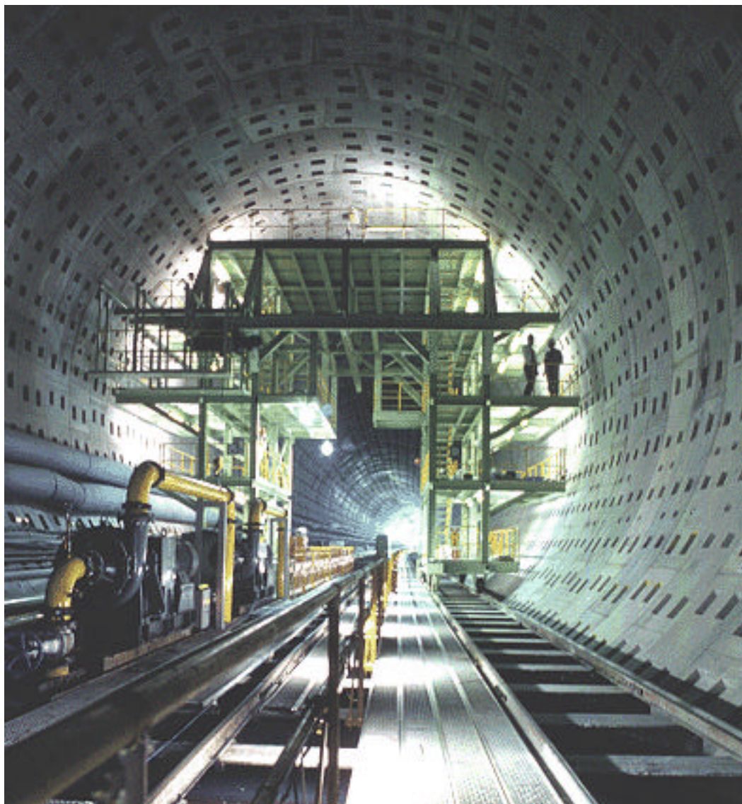
工事中の地下放水路
