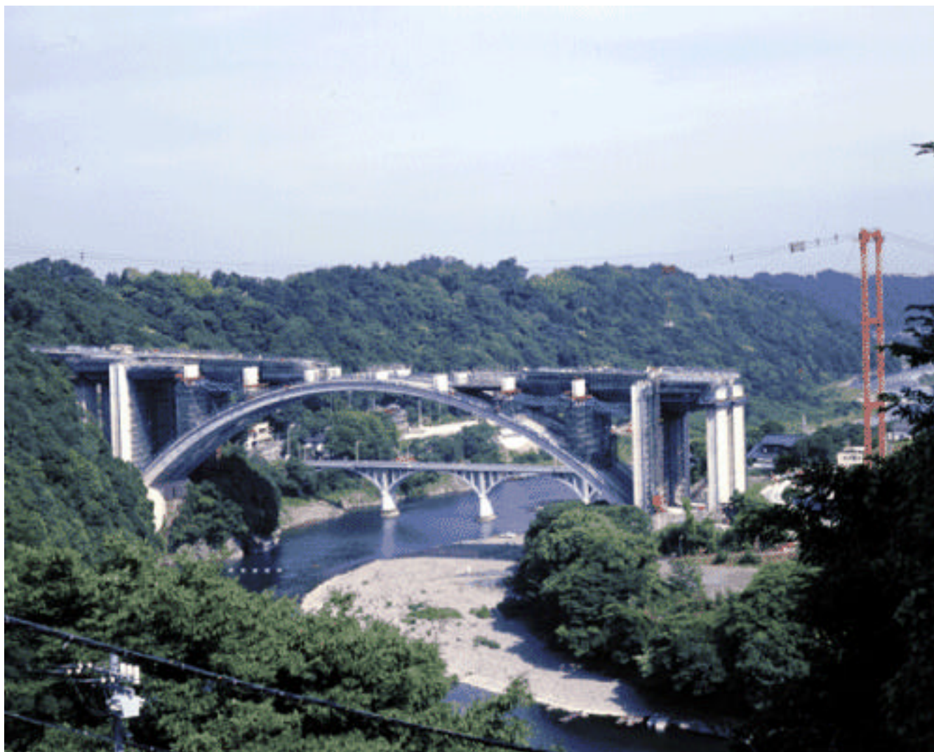
周囲との景観調和をめざしてつくられている橋
