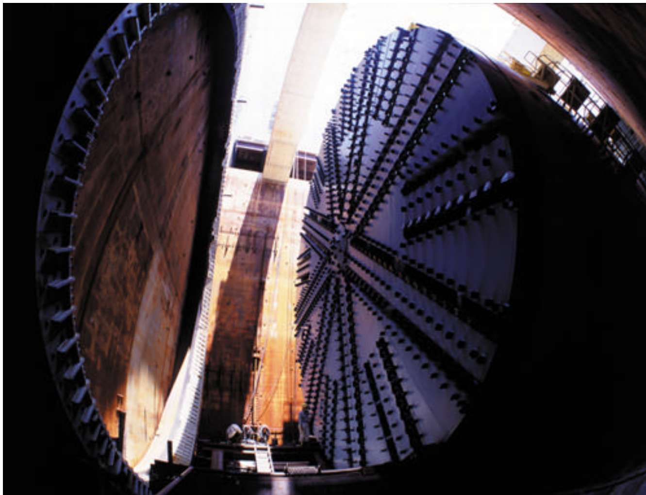
海底トンネルを掘るシールドマシン
