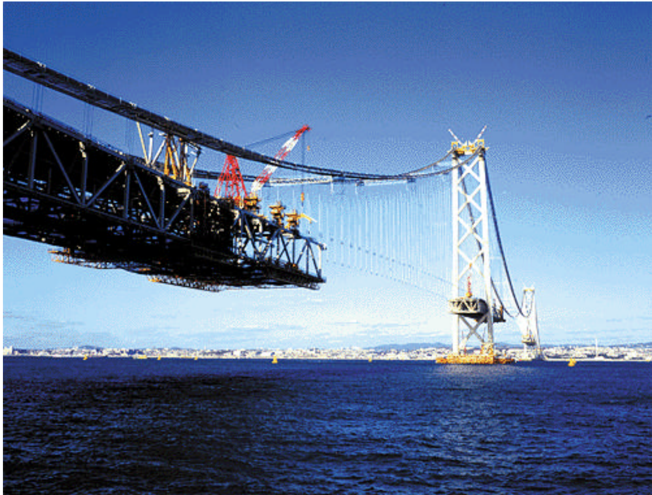
明石海峡大橋（工事）
