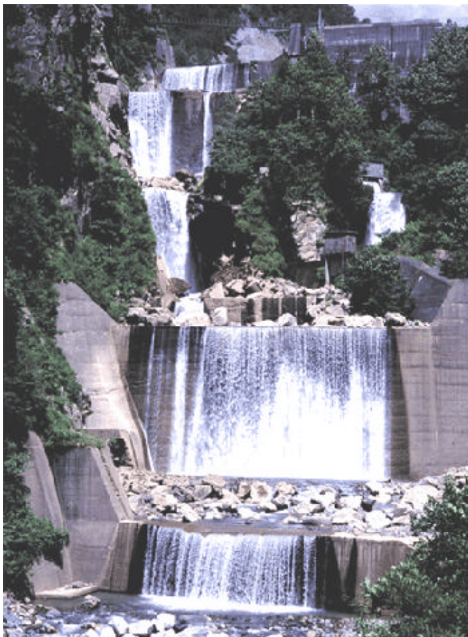
山の中につくられた砂防ダム
