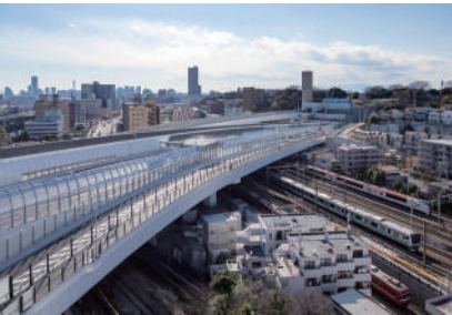
横浜北線鉄道 (JR、京急) 交差点 新設工事
