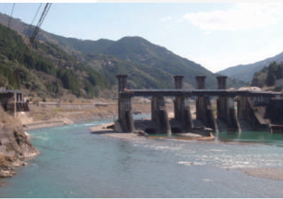
荒瀬ダム本体等撤去工事
