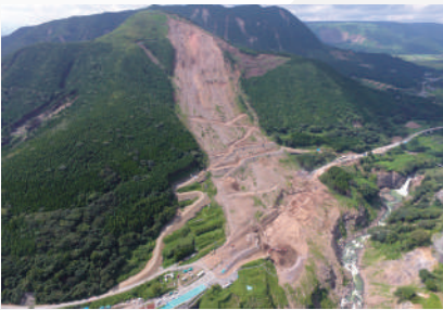
阿蘇大橋地区斜面防災対策工事
