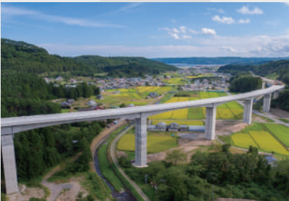
国道45号夏井高架橋工事における i-Bridge の取組み
