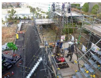
写真 2 法面探査ボーリング状況
