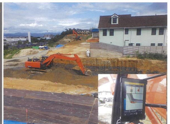
写真1 3次元設計データおよびマシンガイダンスによる構造物掘削の状況
