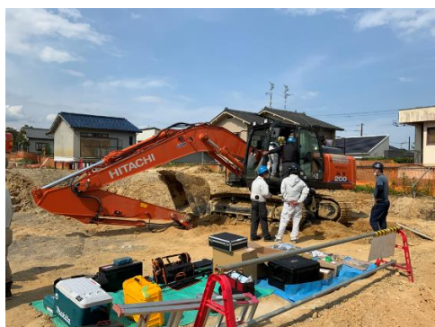
写真4 ICT 建機 (ICT 機器類取付状況)
