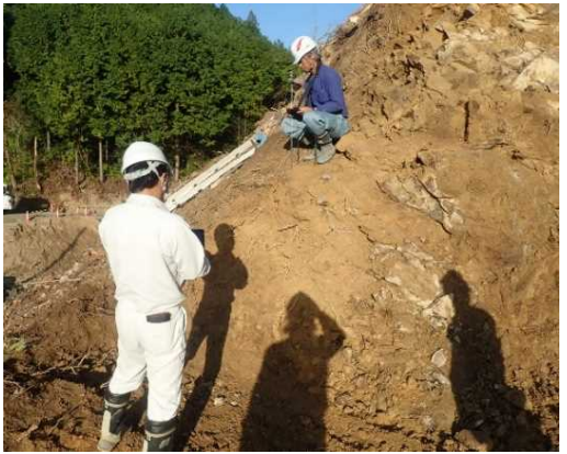
【立会現場の状況】
