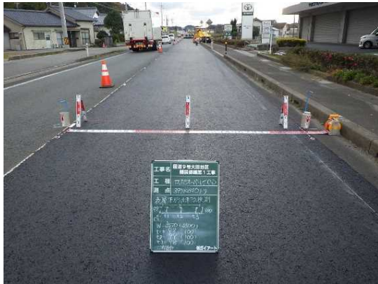
【昼間施工状況】
