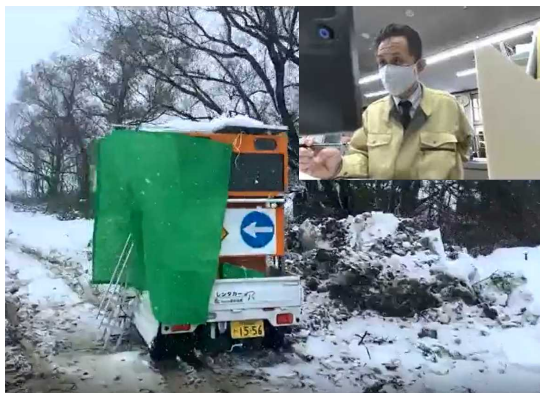
【立会状況（監督側）】
