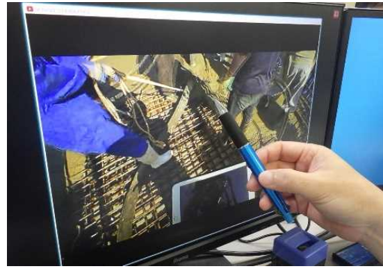
【見えづらい箇所を確認した様子】
