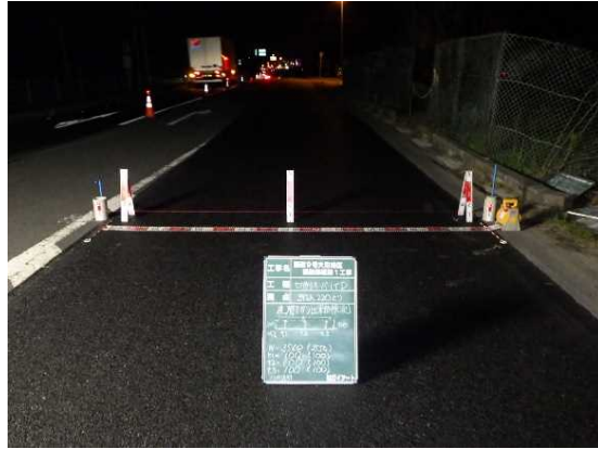
【夜間施工状況】
