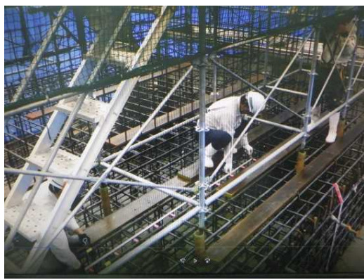
【立会状況 (現場側)】
