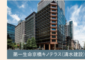
第一生命京橋キネテラス(清水建設)
