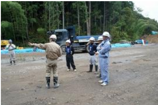
掘削積込作業実技前指導
