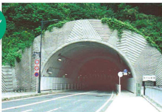
トンネルの出入り口を周辺との調和がとれるデザインにしています。このデザインは雨水による汚れ防止にも効果があります。
