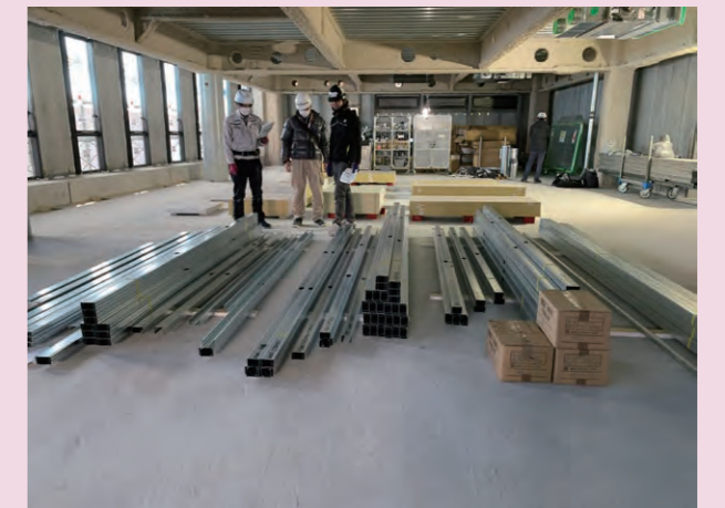
プレカット荷配り
