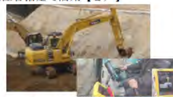
3) ICT建築土工 試行
