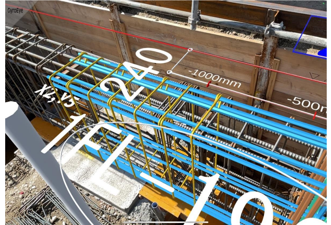
GyroEyeによる配筋モデルと現場の重ね合わせ状況
