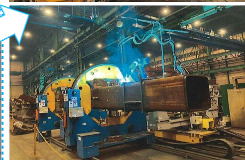
承認後鉄骨製作
