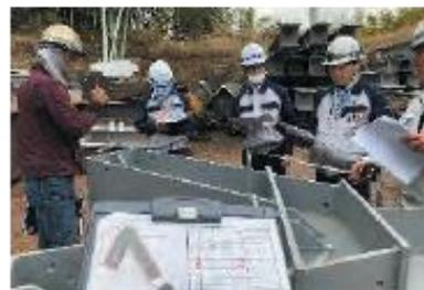
BIMモデルを用いた鉄骨仮組検査
