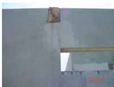
問題も発生する。施工順番間違いによるひび割れ、狭い隙間に別のパネルを挿入(傷付け、割れ)。
