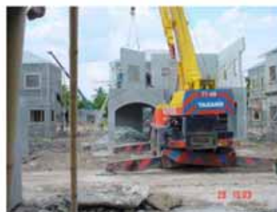
現場では移動式クレーンでプレファブ部材を吊り上げ、組立てていく
