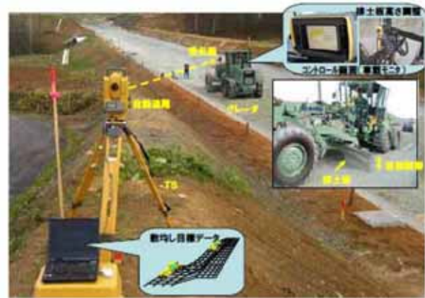
グレーダのマシンコントロール技術(例)
