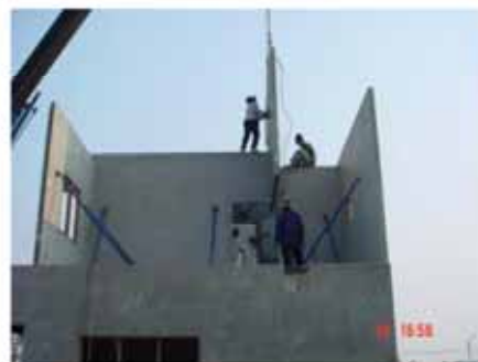
問題も発生する。施工順番間違いによるひび割れ、狭い隙間に別のパネルを挿入(傷付け、割れ)。
