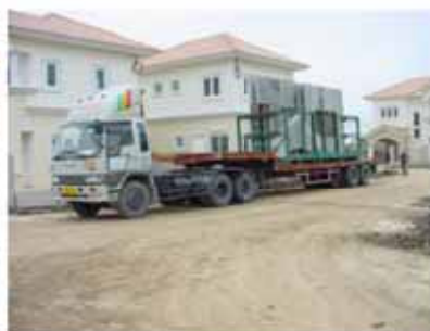
パネル部材をトラックで現場まで運ぶ。
