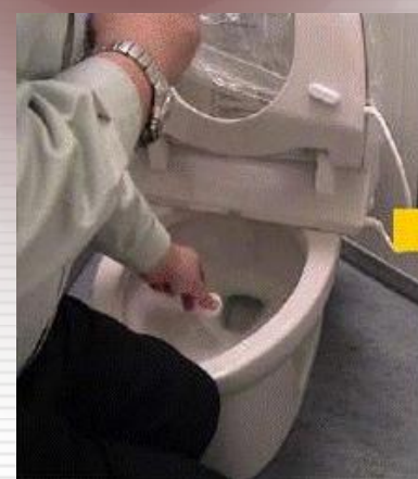
排水管の通水検査
