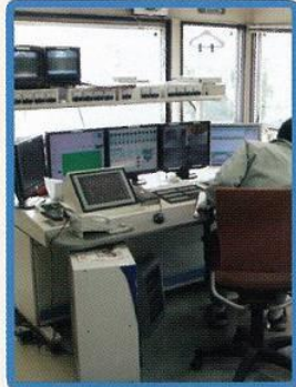
出荷管理装置室
