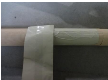
⑦保温材接続テープを配管に巻き付けて片側完成
