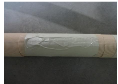
⑥補修テープを接着させる
