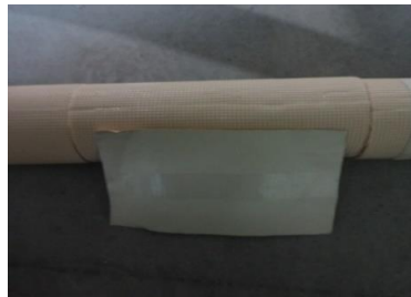
⑤補修テープを適度な長さで切る
