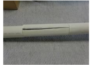
③保温材を押し付けてしっかりと接着させる
