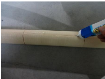
④縦にさいた部分にも接着剤を塗り接着させる
