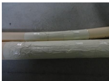
⑩ガス管、液管共同様に施工
