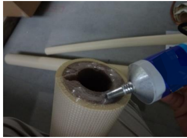
②保温材の切り口にまんべんなく接着剤を塗る
