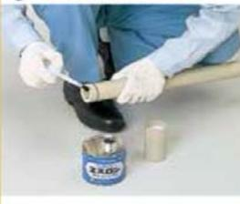
継手の内面と、管端面及び管の外面に、エスロン接着剤 (No.73Sブルー、No.75SブルーN、No.73S、No.75S、No.73S UV) を均一に塗布してください。
