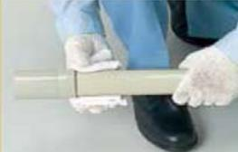
管が継手より抜け出なくなるまで管と継手を保持します。(30秒以上保持)
