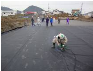
掘削・遮水シート融着
