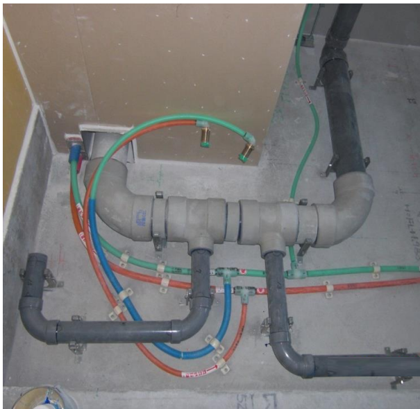
施工例（貫通ブロックと排水ブロック）
