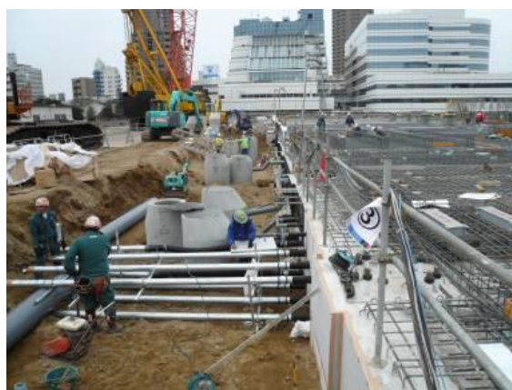
外構配管先行施工の事例
