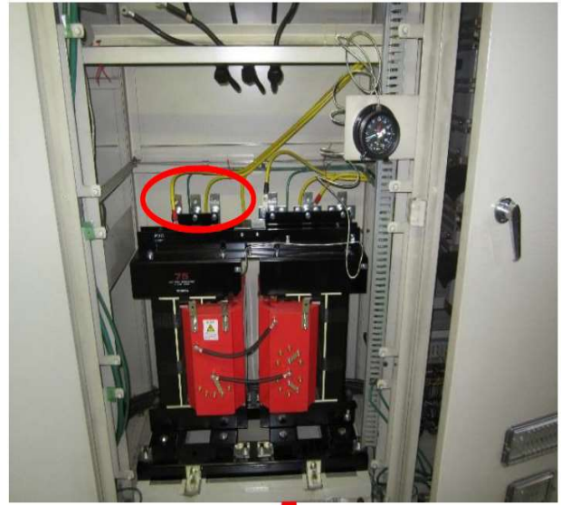
新設 設置状況(一次側端子接続前)
