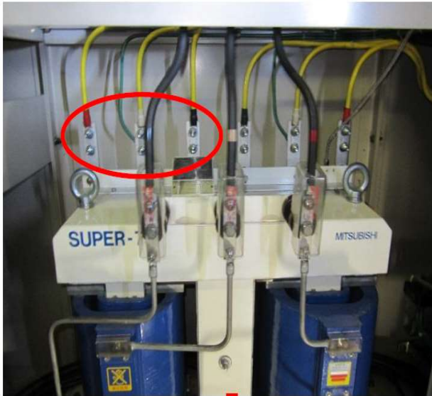
既設 設置状況(工事着手前)
