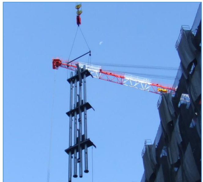
ライザー配管工法
