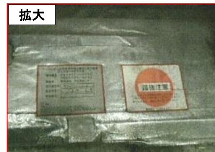
施工記録(写真)
