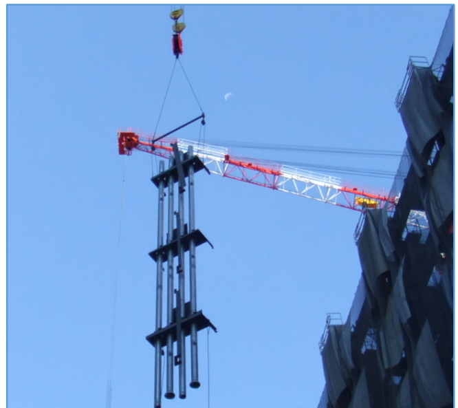
ライザー配管工法
