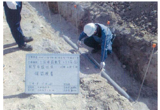
土間配管検査の例
