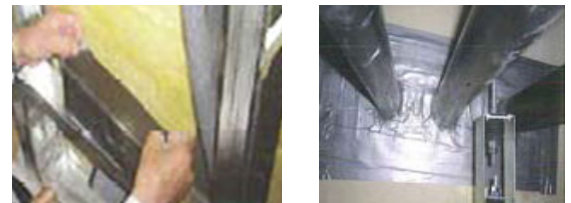
鉛シート巻き 例 (左：コンセントボックス、右：配管貫通部)
