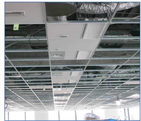
天井器具 設置工事
