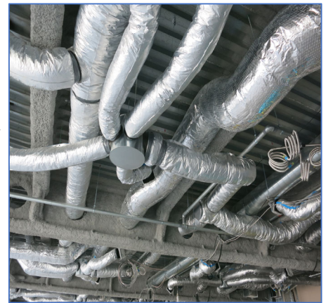
天井内設備 先行工事
