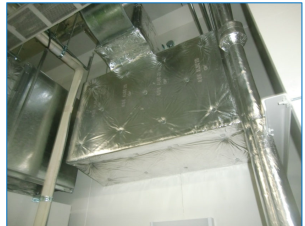
施工状況写真
