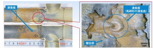
■異種金属腐食の例
