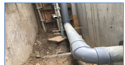
例) 建物周囲の配管工事
