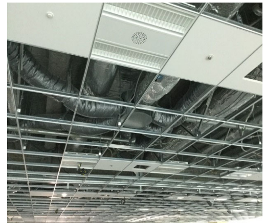
天井内施工状況
