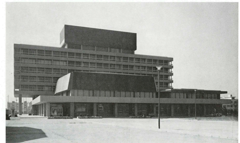
北面全景 North side exterior
