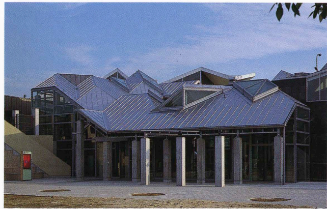
北側エントランス外観 North entrance.
