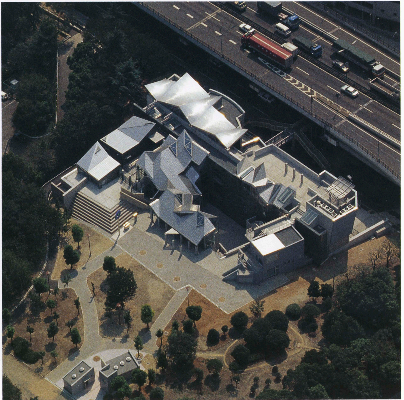
上空より見る 全景 Aerial view.
