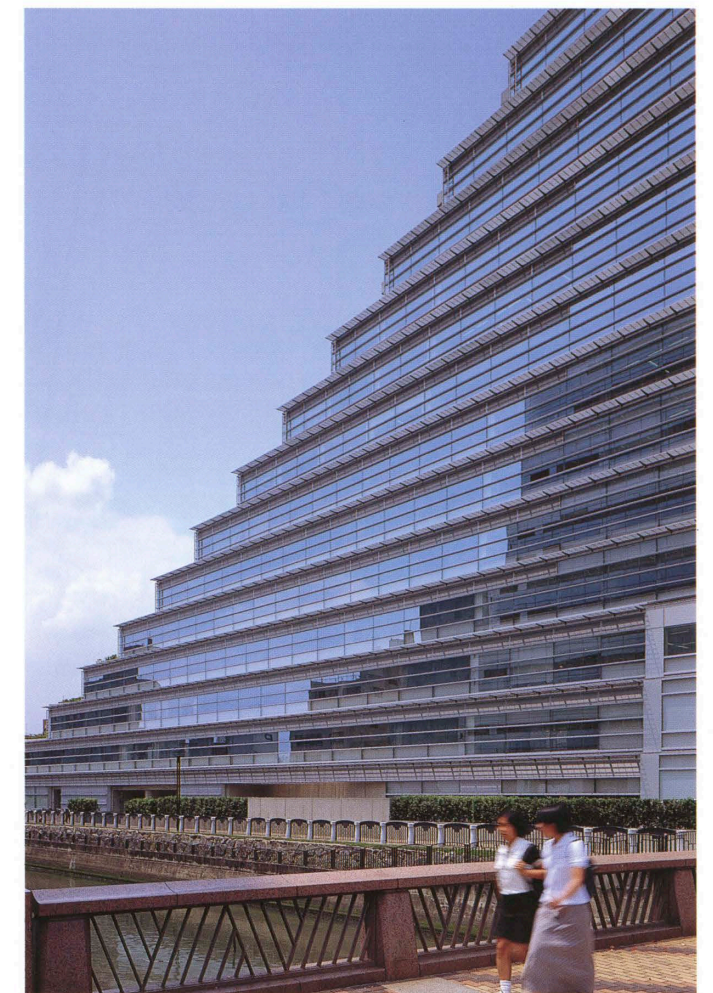
カーテンウォールの東側外観 Exterior of the glass curtain wall on the east.
