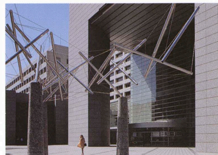
北側プラザより見る彫刻はケネス・ネルソン作 View from the plaza on the north.
