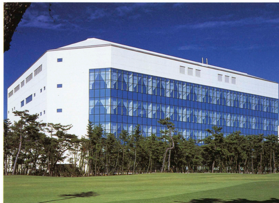
ワールドコンベンションセンター・サミットの東側全景 General view of the World Convention Center Summit from the east.
