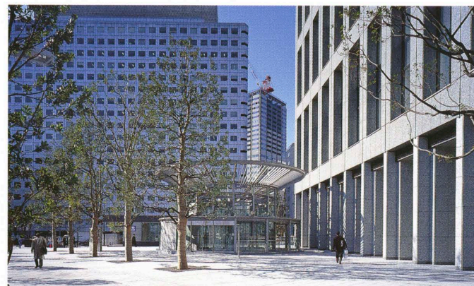
南東側の広場 Open square on the southeast.
