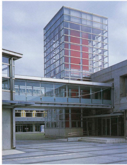
アリーナへ渡るブリッジ The bridge that extends to arena.
