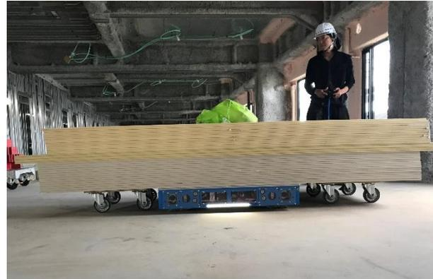
台車を利用した長尺石膏ボードの搬入
