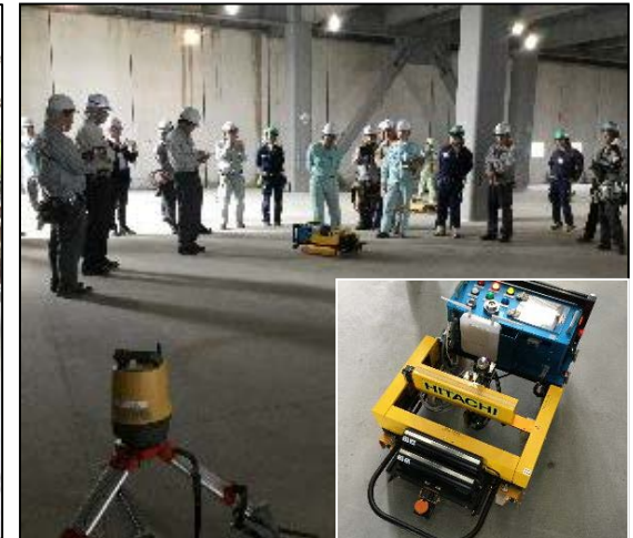
BIMデータを駆使して出来形検証やロボットで墨出しを試みる
