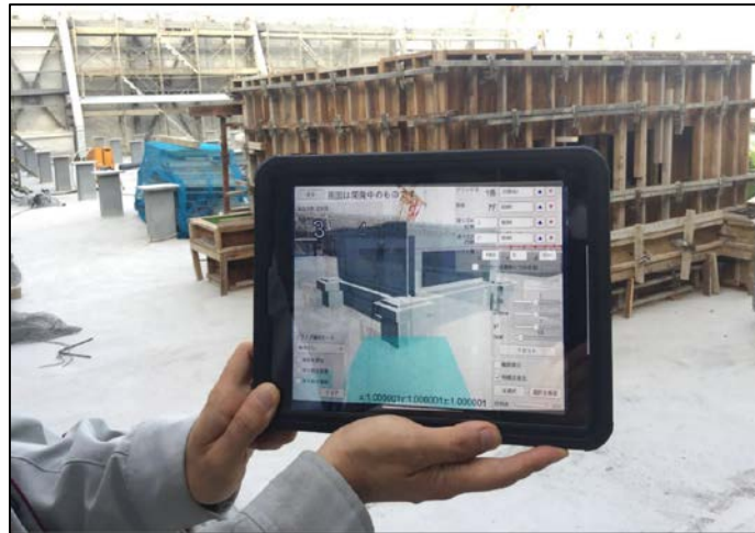
BIMデータを駆使して出来形検証やロボットで墨出しを試みる
