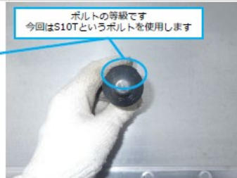
2024.1.29 PCユニット同士をボルトで接合します。写真は仮ボルトを入れている状態です。
