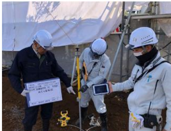
杭ナビにて杭精度管理 計測が簡易になり、ミス防止
