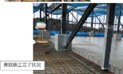
差筋施工完了状況
