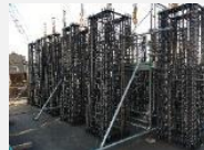
基礎柱・梁の地組施工
