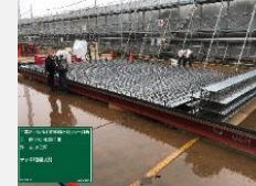
デッキ地組施工
