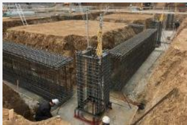
基礎柱・梁の地組施工
