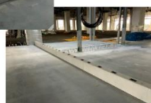
PC腰壁設置完了 コンクリート打設
