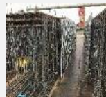
基礎ラス型枠地組施工取付
