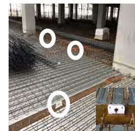
吊ピース塗装状況
