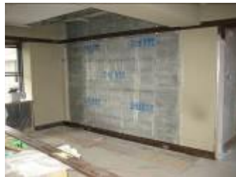
耐震壁の施工後 (3Q-Wall 工法)
