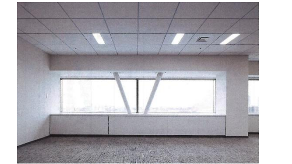
写真-4 制振部材設置後仕上げ状況
