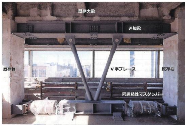
写真-3 制振部材・周辺架構設置状況
