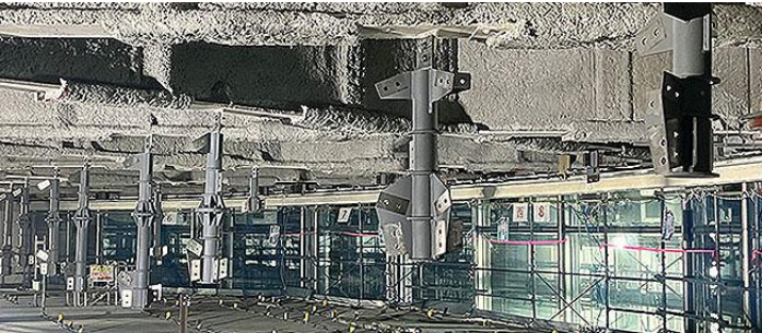
写真 3 新設された支持鋼材
